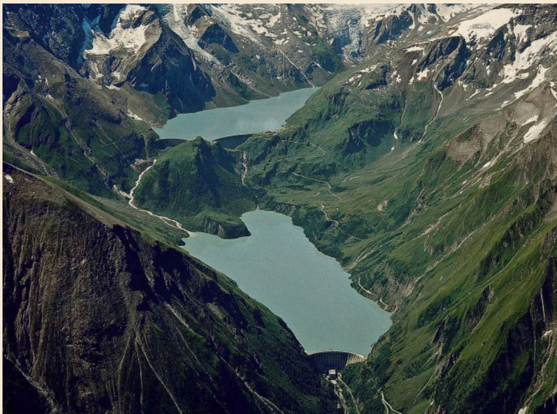
Ober- und Hauptstufe der Kraftwerksgruppe Kaprun: Das Pumpspeicherkraftwerk im Salzburger Land ist eines der größten in den Alpen. Bei Stromüberschuss wird Wasser in das obere Becken gepumpt.
