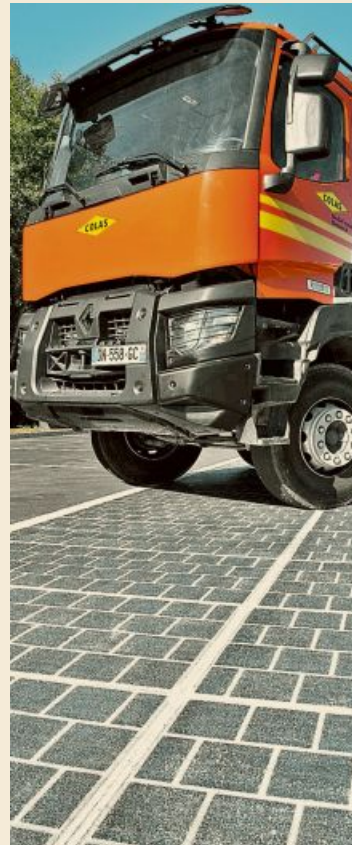
Teures Pflaster: Die Solarstraße erzeugt auch Strom.
