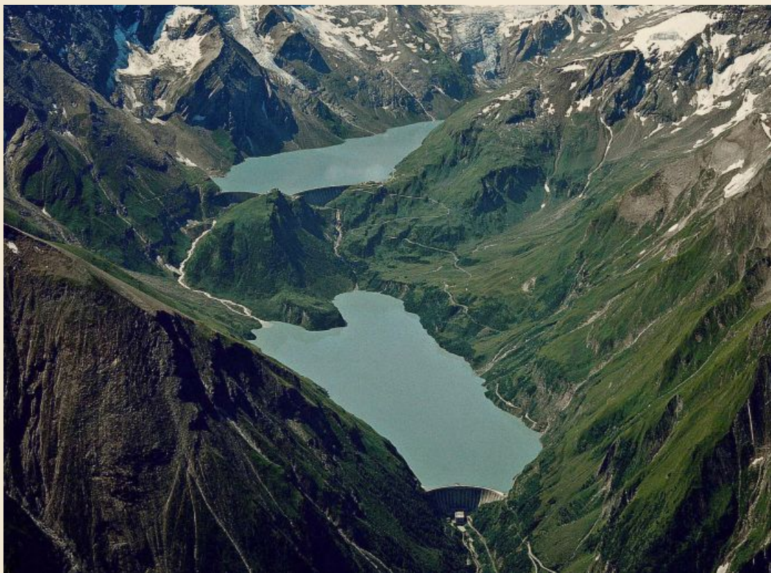
Ober- und Hauptstufe der Kraftwerksgruppe Kaprun: Das Pumpspeicherkraftwerk im Salzburger Land ist eines der größten in den Alpen. Bei Stromüberschuss wird Wasser in das obere Becken gepumpt.
